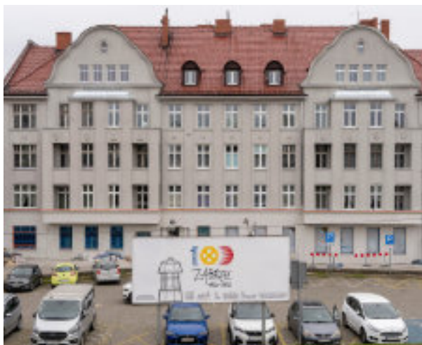
► ...i przy placu Dworcowym Fot. UM Zabrze
