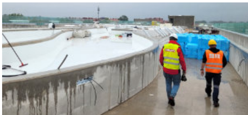
► Na dachu obiektu powstanie ogólnodostępny ogród Fot. UM Zabrze
