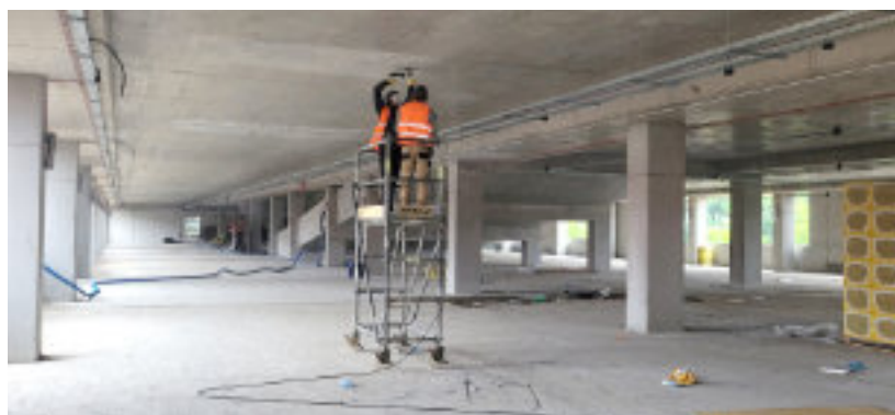
► Trwają roboty instalacyjne wewnątrz centrum Fot. UM Zabrze
