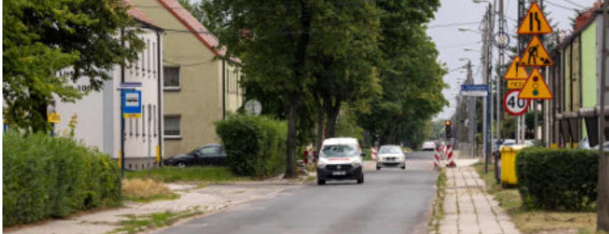
► Ulica 11 listopada zostanie wyremontowana Fot. UM Zabrze
