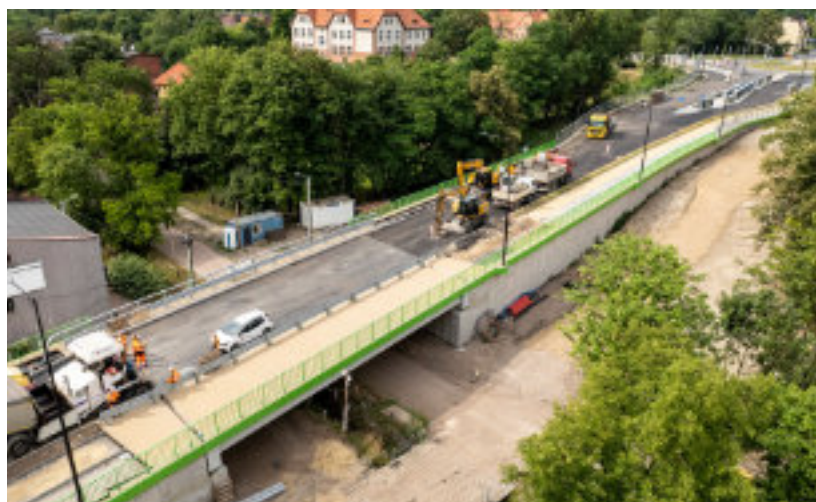
► Na budowie trwają intensywne prace Fot. UM Zabrze
