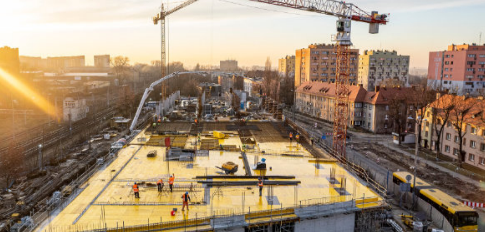
► Przy ul. Goethego trwają intensywne prace Fot. UM Zabrze
