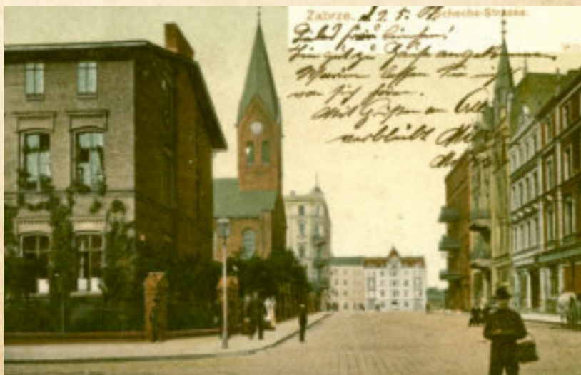
► Budynek Starostwa Powiatowego w Zabrzu, z dobudowanym (1892-1894) skrzydłem południowym, mieszczącym na pierwszym piętrze mieszkanie starosty. Fot. Pocztówka ze zbiorów Włodzimierza Wysockiego
