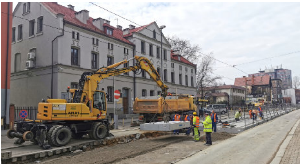
► Wymiana torowiska tramwajowego wzdłuż ul. Wolności Fot. UM Zabrze
