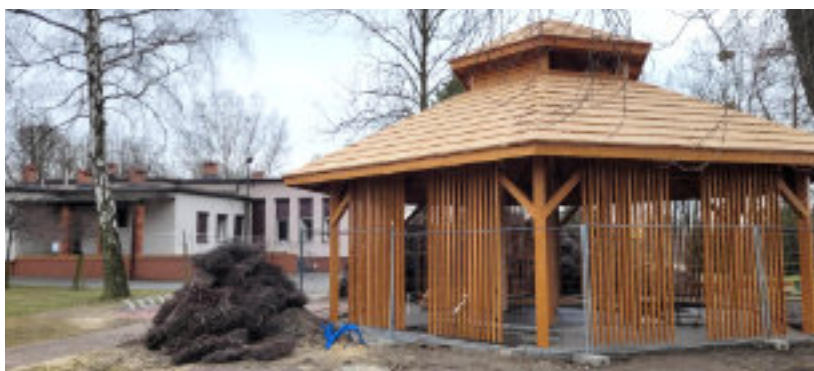
► Tężnia powstająca przy Dzielnicowym Ośrodku Kultury w Kończycach Fot. UM Zabrze
