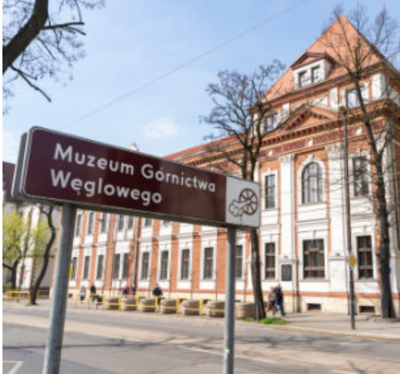
► Miejscem konferencji była wyremontowana siedziba MGW przy ul. 3 Maja Fot. UM Zabrze
