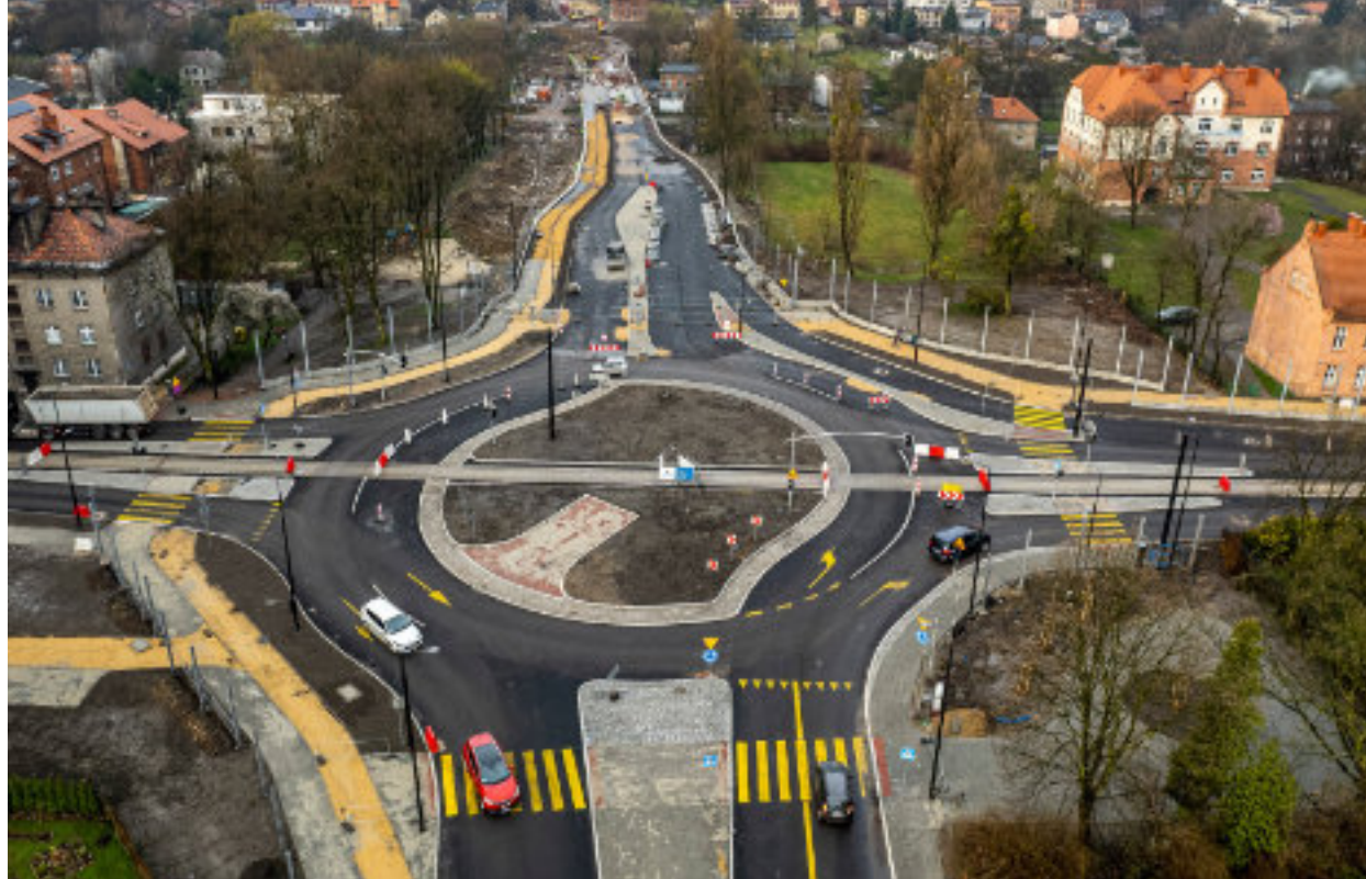
► Przedłużenie alei Korfantego ma być gotowe jesienią Fot. UM Zabrze
