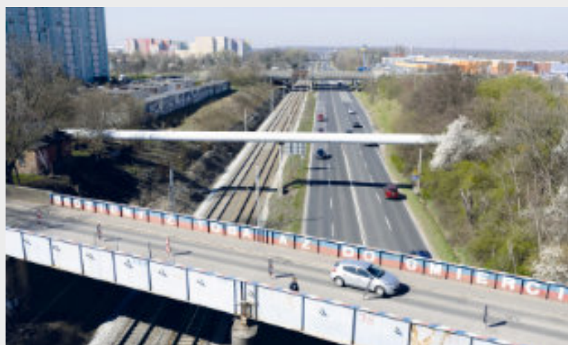
► Objęty przebudową wiadukt Fot. UM Zabrze
