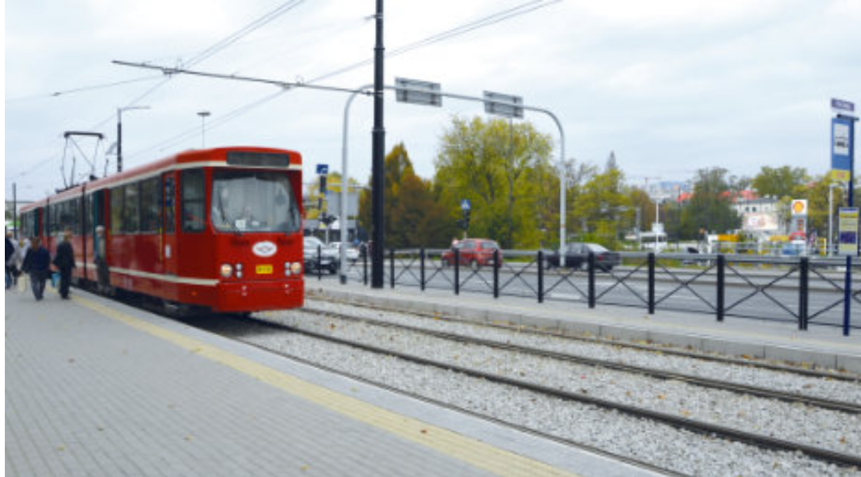
► Nowe torowisko wzdłuż ul. Religi Fot. UM Zabrze
