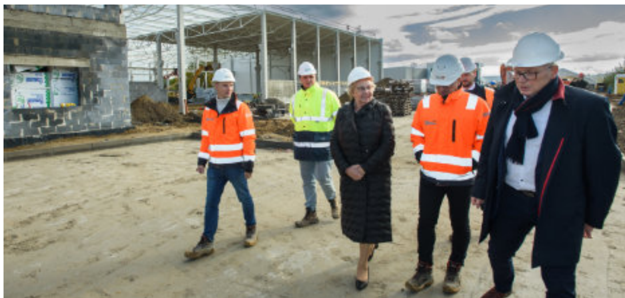
► Prezydent Zabrza Małgorzata Mańka-Szulik z przedstawicielami inwestora na placu budowy jednego z obiektów Fot. UM Zabrze
