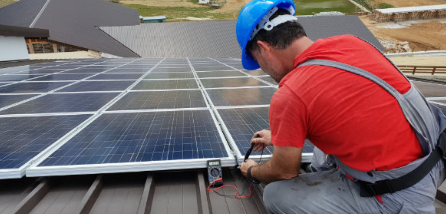
► Montaż instalacji fotowoltaicznej Fot. pixabay
