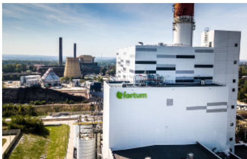
► Należąca do fińskiego koncernu Fortum Elektrociepłownia Zabrze Fot. Fortum
