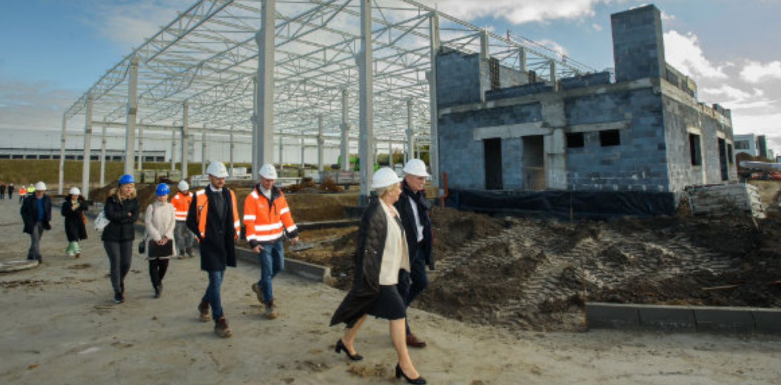
► Przedstawiciele inwestora i samorządu na placu budowy Fot. UM Zabrze
