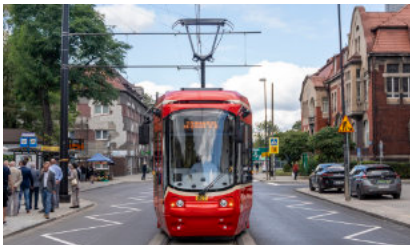
► Modernizacji torowisk towarzyszyła wymiana nawierzchni Fot. UM Zabrze
