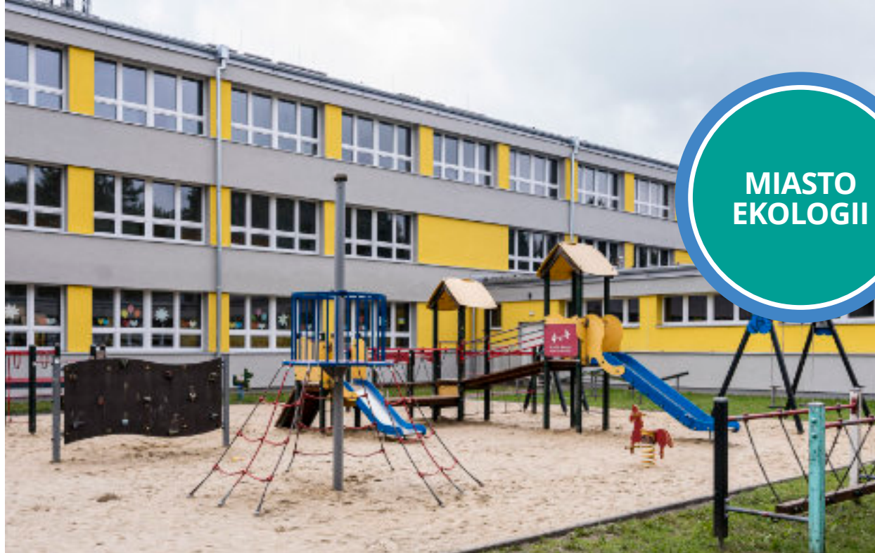
► Dzięki programowi termomodernizacji obiektów użyteczności publicznej swoje oblicze zmieniają kolejne szkoły i przedszkola Fot. UM Zabrze
