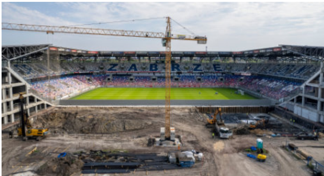
► Na budowie zachodniej trybuny Areny Zabrze trwają intensywne prace Fot. UM Zabrze
