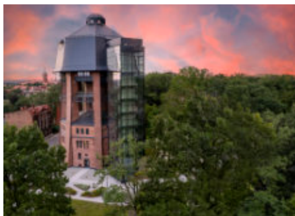
► Rewitalizacja wieży ciśnieni przy ul. Zamoyckiego Fot. UM Zabrze
