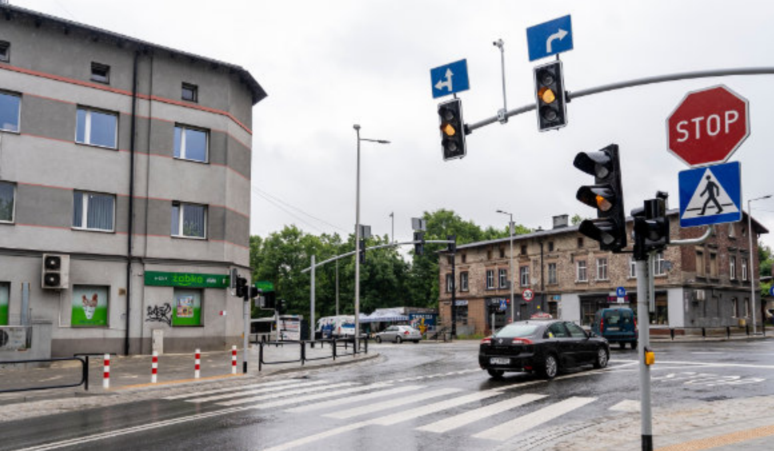
► Tak prezentuje się przebudowane skrzyżowanie Fot. UM Zabrze
