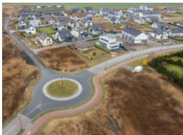
► Rozbudowa sieci dróg na osiedlu Słoneczna Dolina Fot. UM Zabrze
