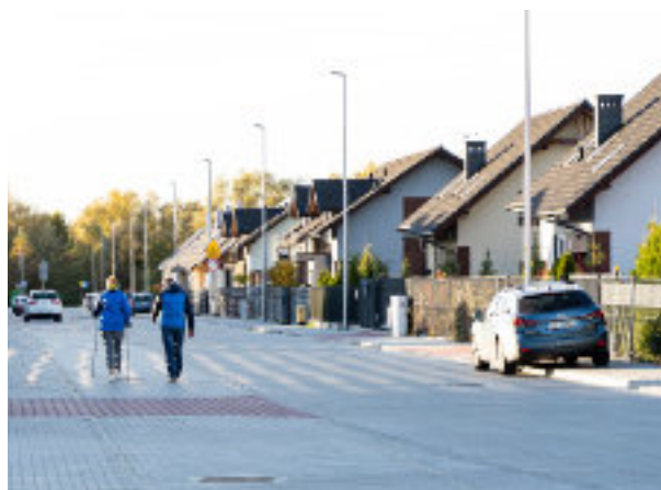
► Budowa nowych dróg w Grzybowicach Fot. UM Zabrze
