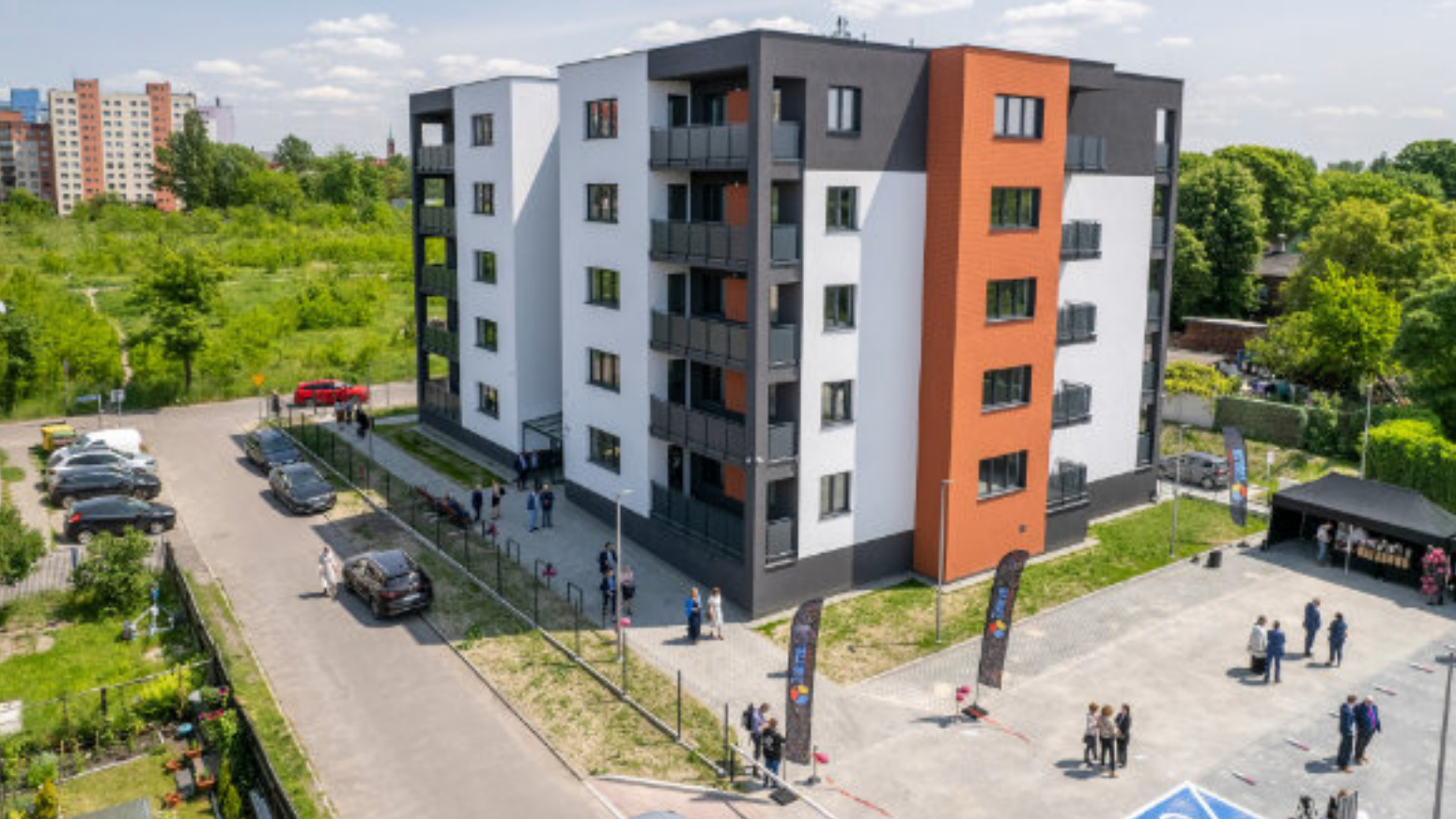
► W budynku przy ul. Żeromskiego powstało 35 nowoczesnych mieszkań Fot. UM Zabrze
