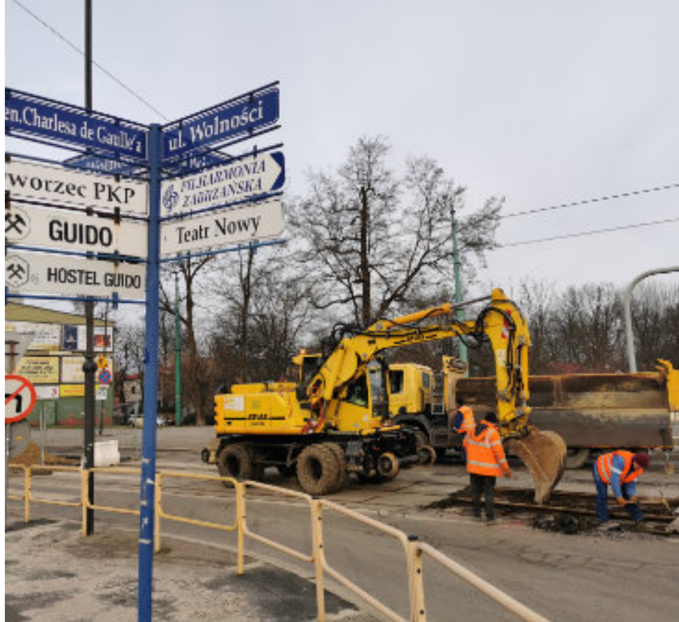
► Remontowany odcinek ul. Wolności Fot. UM Zabrze
