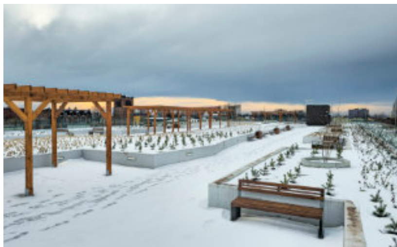
► Na dachu obiektu powstał ogród Fot. UM Zabrze
