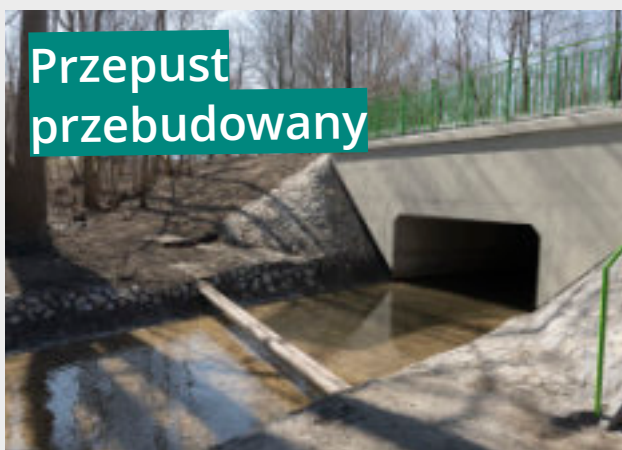
Do ruchu oddany został przebudowany przepust nad Czarniawką w rejonie ulic Paderewskiego i 3 Maja
