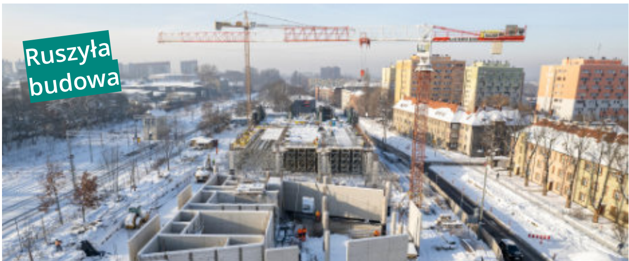
Ruszyła budowa centrum przesiadkowego przy ul. Goethego
