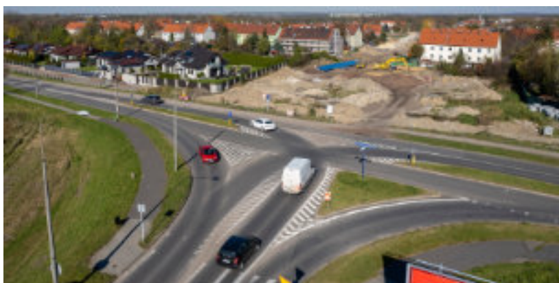
► Prace nad przedłużeniem alei Korfantego Fot. UM Zabrze
