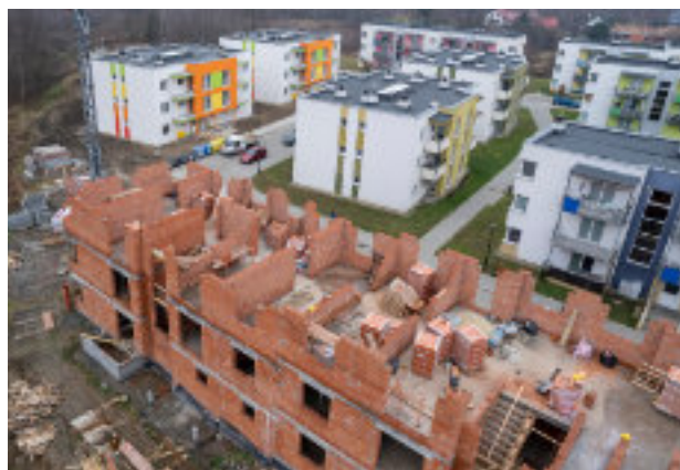
► Budowa kolejnych nowych mieszkań Fot. UM Zabrze
