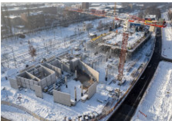
► Budowa centrum przesiadkowego przy ul. Goethego i w Rokitnicy
