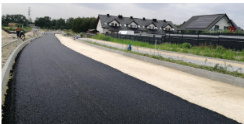
► Rozbudowa układu drogowego na osiedlu Słoneczna Dolina Fot. UM Zabrze
