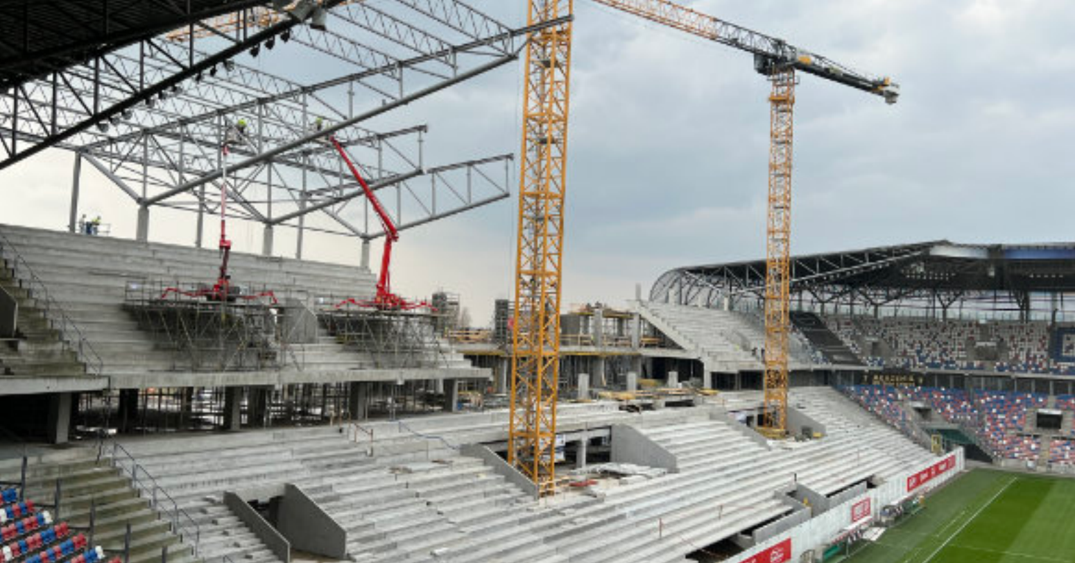
► Na budowie czwartej trybuny Areny Zabrze trwa montaż elementów zadaszenia Fot. Stadion w Zabrzu Sp. z o.o.
