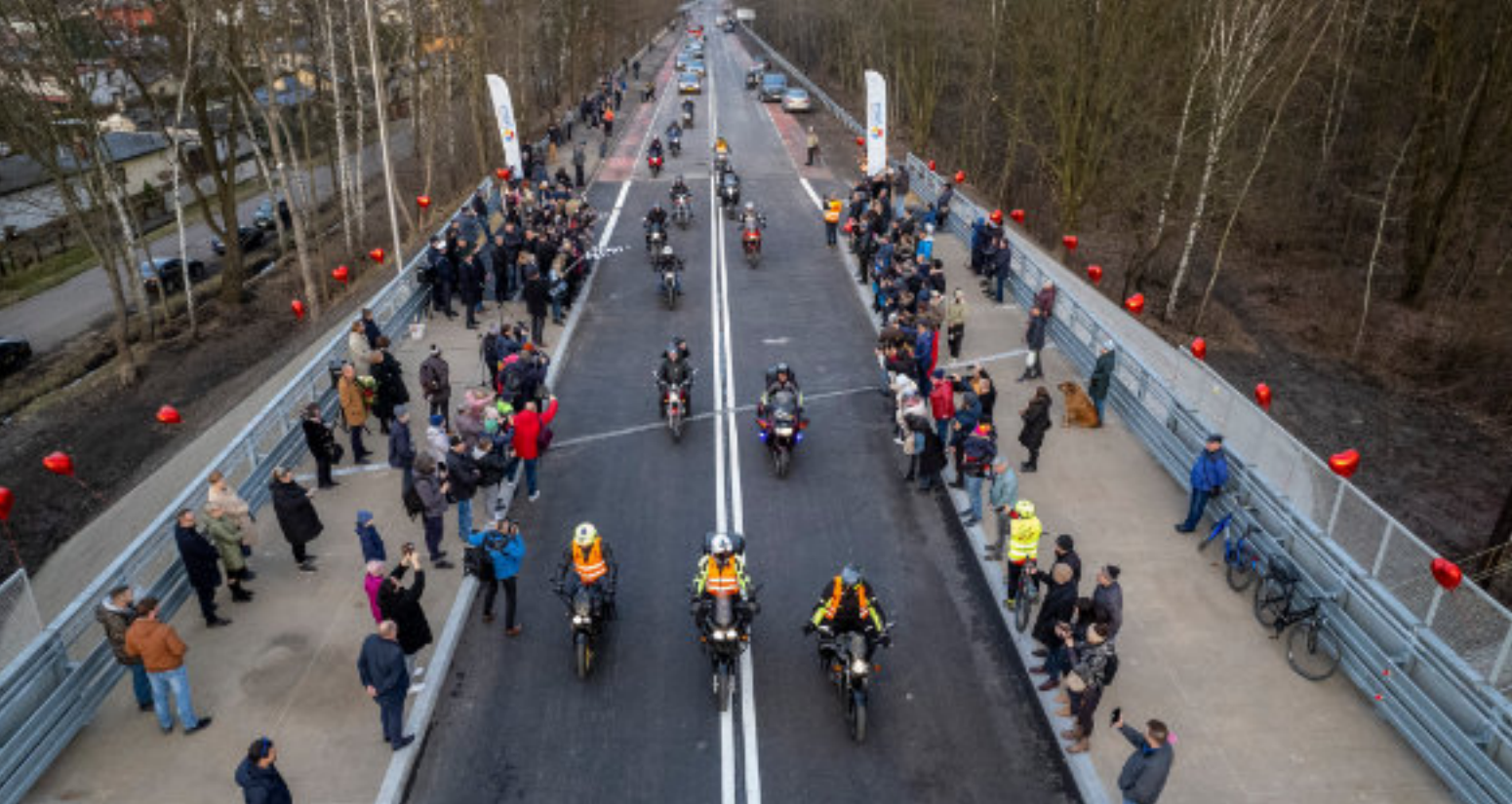
► Jako pierwsi otwartym wiaduktem przejechali motocykliści Fot. UM Zabrze
