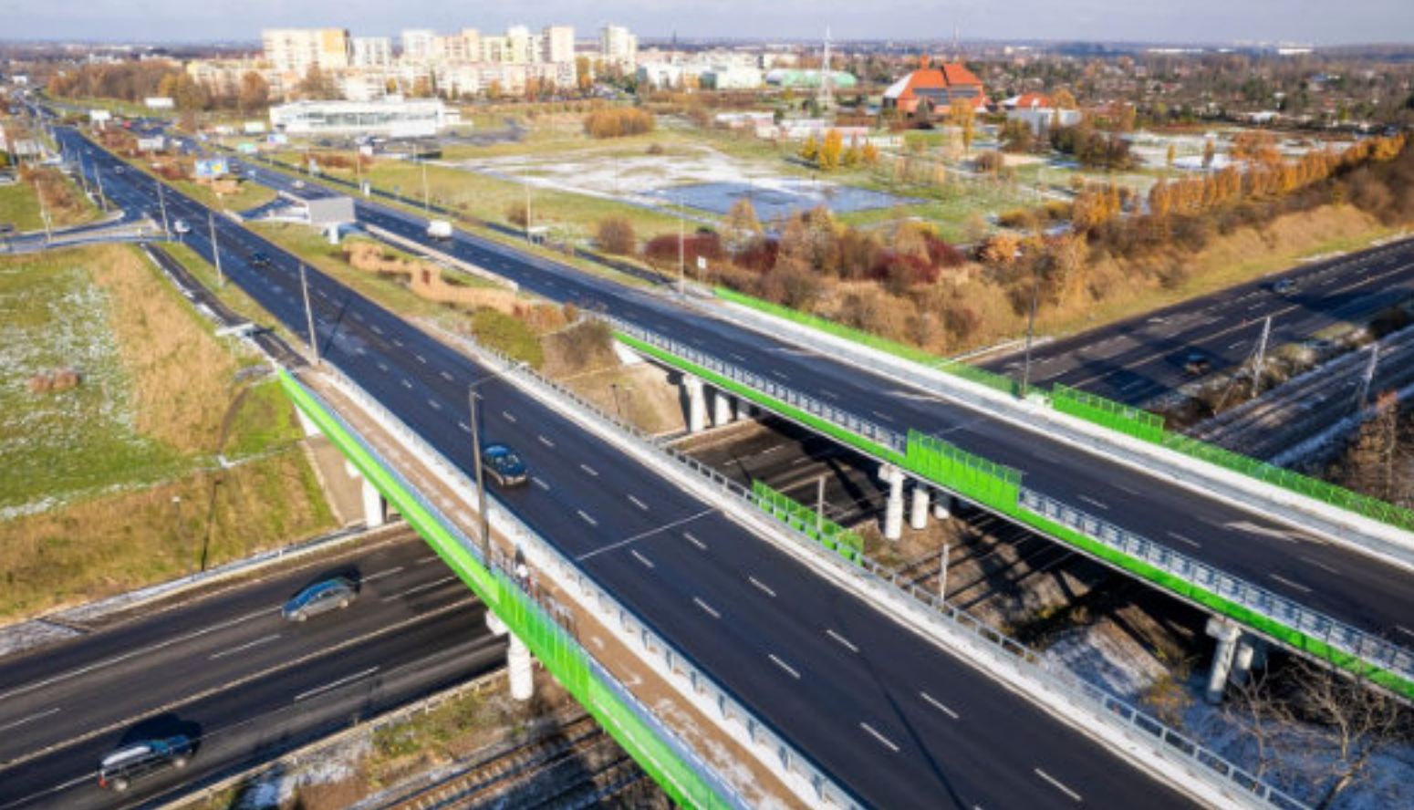
► Wyremontowane wiadukty w ciągu alei Korfantego Fot. UM Zabrze
