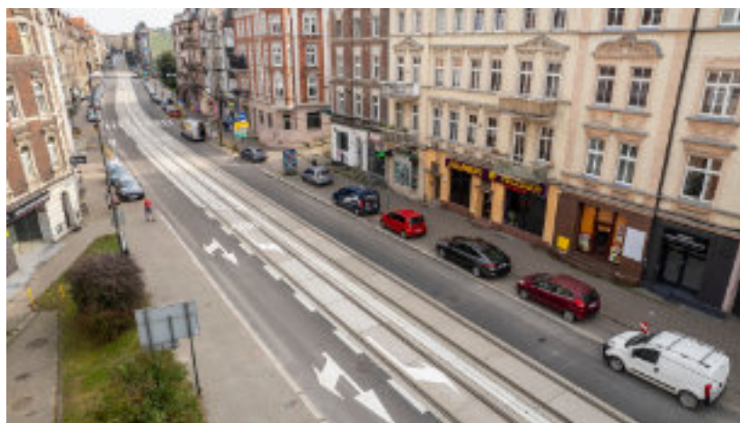
► Wyremontowany odcinek ul. Wolności w centrum Fot. UM Zabrze
