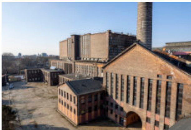
► Rewitalizacja kompleksu dawnej elektrowni Fot. UM Zabrze
